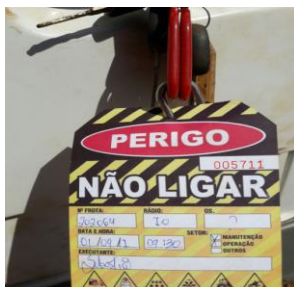
Figura 07 – Chave bloqueada juntamente com o cartão de bloqueio.
