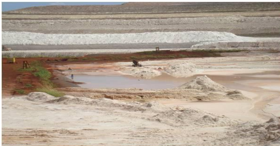
FIGURA 1. Montanha de gesso e seus taludes.
